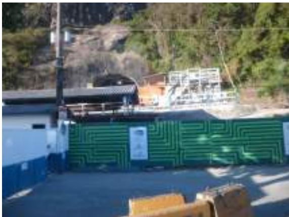
(硬い岩盤を貫通させてアクセスの整備)
