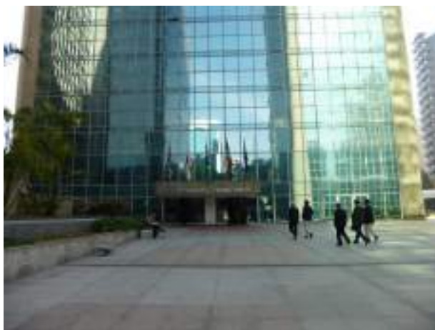
（ブラジルきってのオフィス街、ビルのセキュリティは万全）
